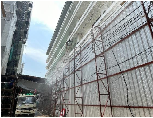
รูปที่ 13 ระบบสเปรย์น้ำลดฝุ่น
