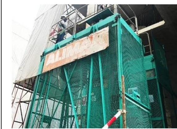
รูปที่ 51 ลิฟต์ขนส่งของของโครงการ
